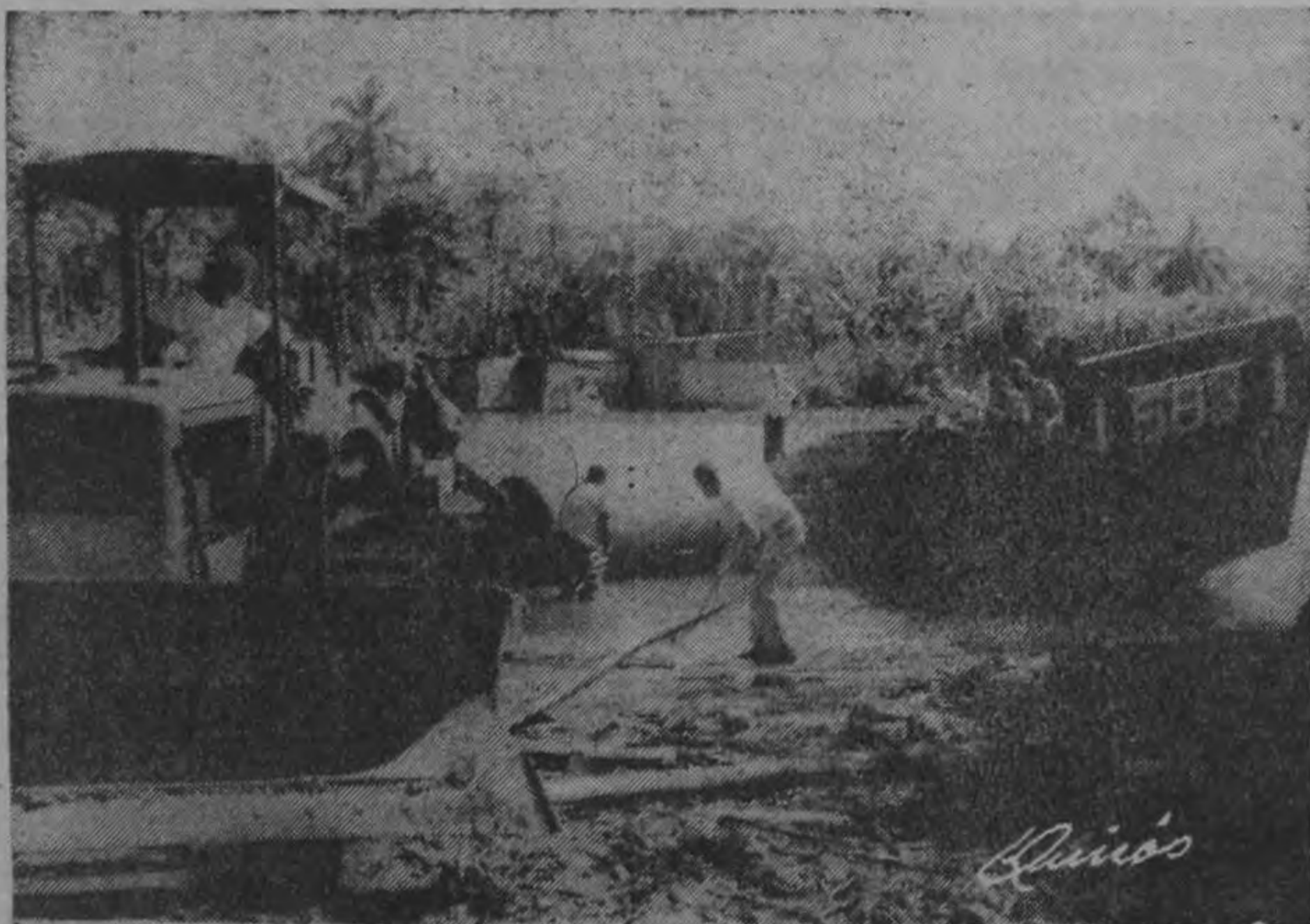
Momento en que los pontones son arrastrados a tierra por medio de un tractor del MT. Personal de la marina norteamericana observa las manio-
